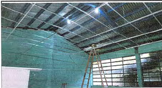
INSTALACIÓN DE CIELO FALSO EN AULAS Y DIRECCIÓN DEL ESTABLECIMIENTO.
