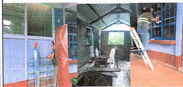
SUSTITUCIÓN DE VENTANAS EN AULAS, DIRECCIÓN Y COCINA.
