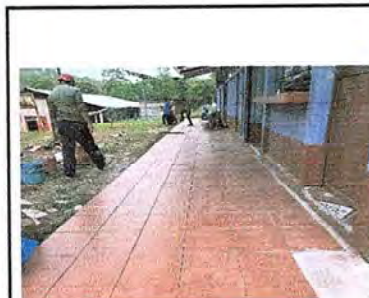
SUSTITUCIÓN DE PISO ENTORTADO POR PISO CERÁMICO DEL CORREDOR DEL ESTABLECIMIENTO
