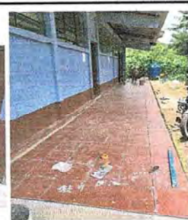
SUSTITUCIÓN DE PISO ENTORTADO POR PISO CERÁMICO DEL CORREDOR DEL ESTABLECIMIENTO
