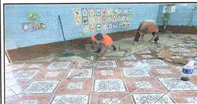
SUSTITUCIÓN DE PISO ENTORTADO POR PISO CERÁMICO EN AULAS, DIRECCIÓN, CORREDOR Y COCINA
